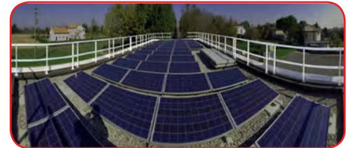
**FOTOVOLTAICO:** i modelli reclinabili sono perfetti per i tetti su cui sono montati impianti fotovoltaici in quanto restano sempre chiusi evitando l'ombreggiamento. Il parapetto viene aperto dall'operatore solo prima delle operazioni di manutenzione e poi chiuso nuovamente.
