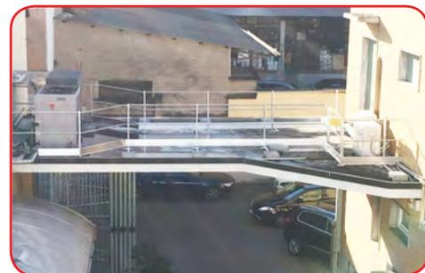
Bastano pochi minuti per ottenere un parapetto comodo, leggero ed inattaccabile dalla ruggine. Ogni modulo è dotato di giunti per creare una continuità lungo tutto il tetto.
