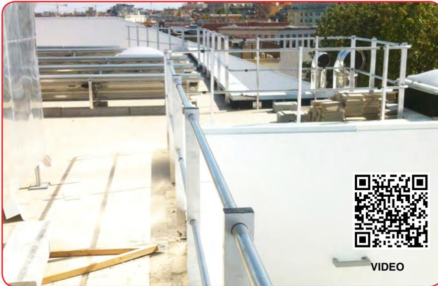
Esempio di Parapetto modello PC1A con fissaggio a pavimento dotato di curve
